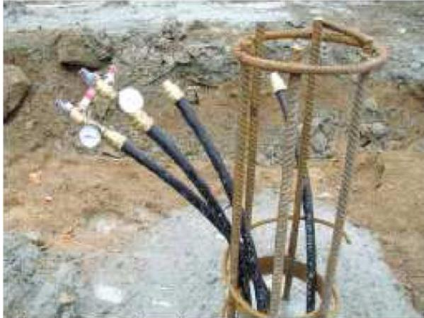
**Tubes et armatures en tête d'un pieu (source : PREBAT)**
