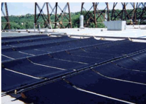
Les capteurs dits « moquette » non vitrés, sont souples mais ont un mauvais rendement. Ils peuvent par exemple servir au chauffage de l'eau d'une piscine, mais pas à la production d'ECS.
