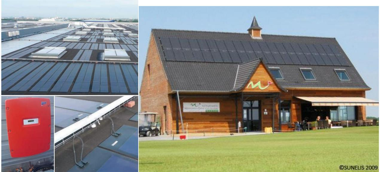
**Membrane photovoltaïque amorphe sur toiture des entrepôts Sisley à Saint-Ouen-l'Aumône (95) - surface de 35000 m<sup>2</sup>, puissance estimée à 848 kWc (source : cahiers techniques du bâtiment n°305 – avril 2011)**
