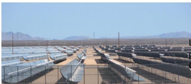
Les centrales à capteurs cylindro-paraboliques (photo : centrale LUZ en Californie de 354 MW)
