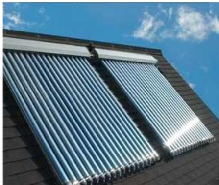
**Les capteurs sous vides, rigides, qui possèdent en général un rendement meilleur que les capteurs plans pour des températures plus élevées (au-dessus de 30°C), et peut servir au chauffage, à la production d'ECS et dans des systèmes de climatisation solaire.**
